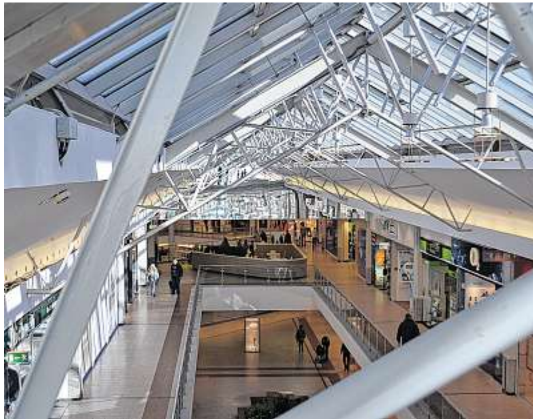
Imposante Dachkonstruktion: Blick von oben in den Weserpark.
